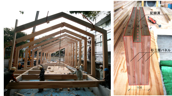
図 2: 建設中の実験住宅（左）とフレームに用意された配線溝（右）．
